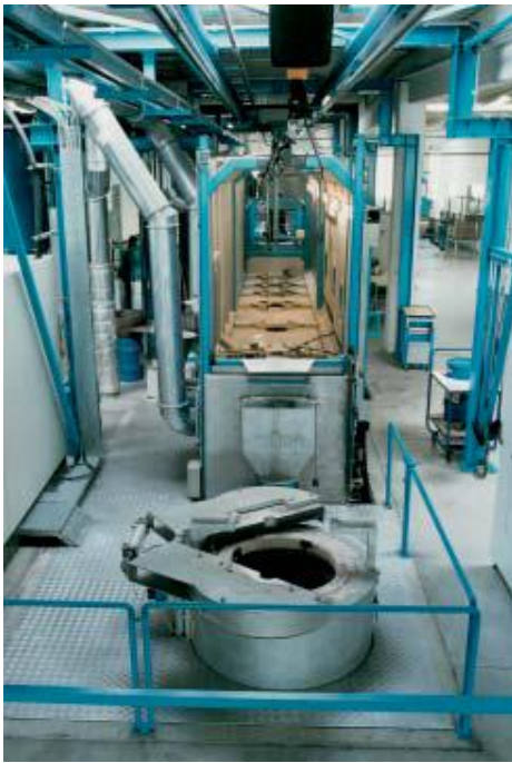
Fig. 9: Instalação CLIN controlada por computador
